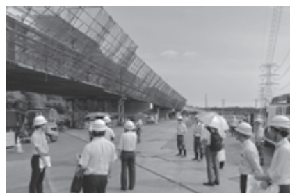
【高谷川高架橋の工事現場】
