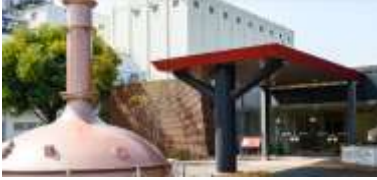
【麒麟ビール取手工場】
